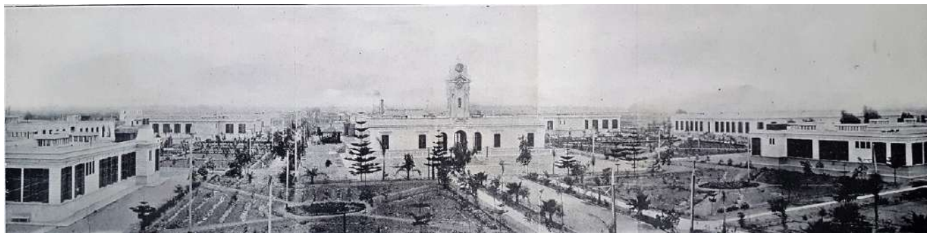
FIGURA 1. Vista general del Asilo Colonia. Fuente: Asilo Colonia de Magdalena, 1920 (38).
